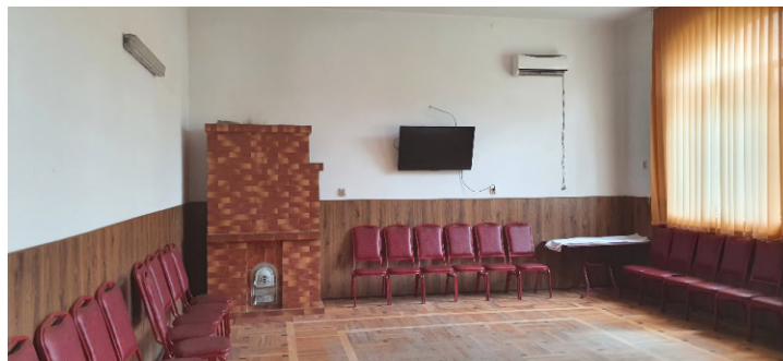
Будинок культури/міської бібліотеки міста Літені. Пічна система опалення
