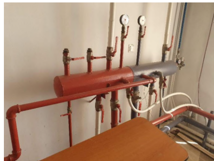
Розподільний колектор теплової енергії та ТЕЦ
